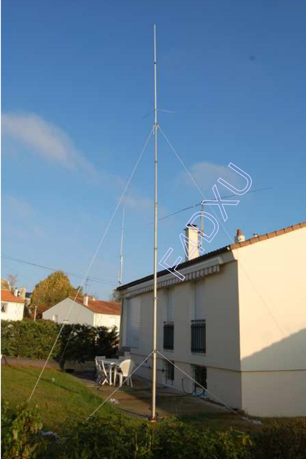
La photo ci-dessus représente l'antenne terminée, la résonance sur 40m est obtenue en court-circuitant la self qui se trouve à la base de l'aérien et la résonance sur 80m est obtenue simplement en ouvrant le court-circuit. Ces performances sur 80m ont très légèrement augmenté par un allongement d'environ 1m de la partie rayonnante.
